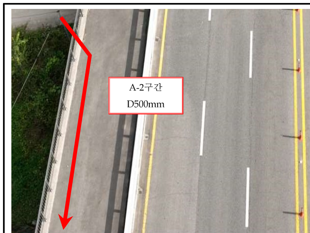
상리교 하부 하천횡단 구간 드론 전경
