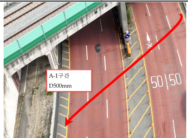
도로 횡단 구간 드론 전경
