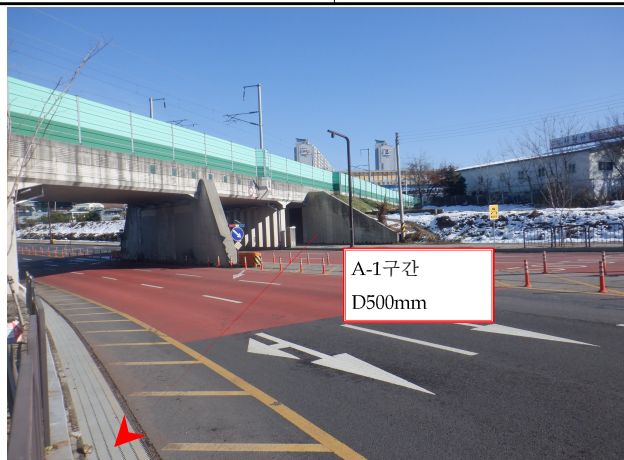
천천리 지하차도 통과 후 도로 횡단구간
