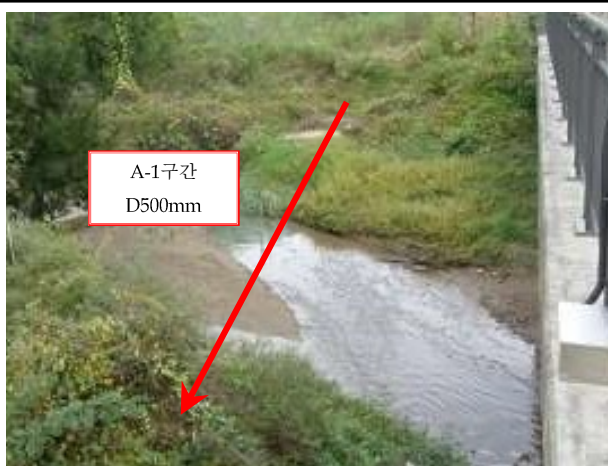
하천 횡단 구간 전경
