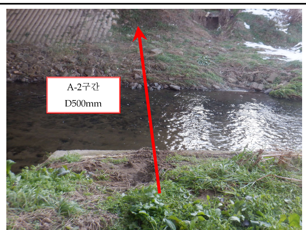
상리교 하부 하천횡단 구간
