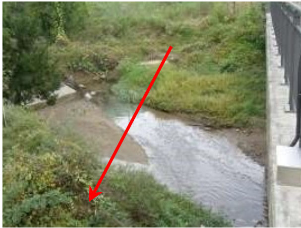
하천 횡단 구간 전경
