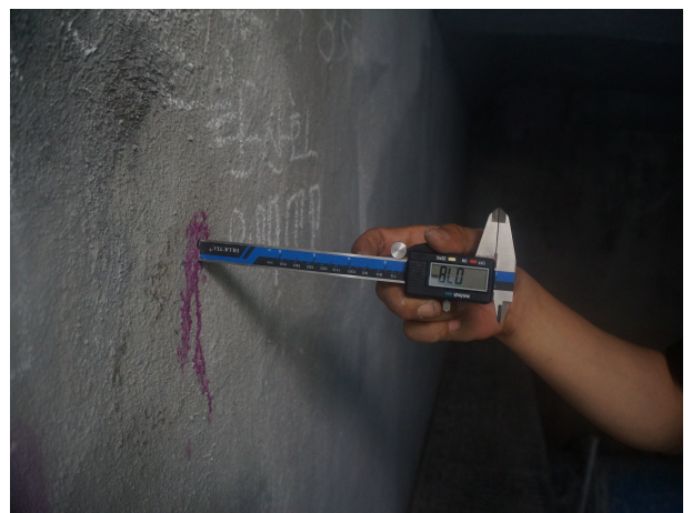
탄산화 시험 전경
